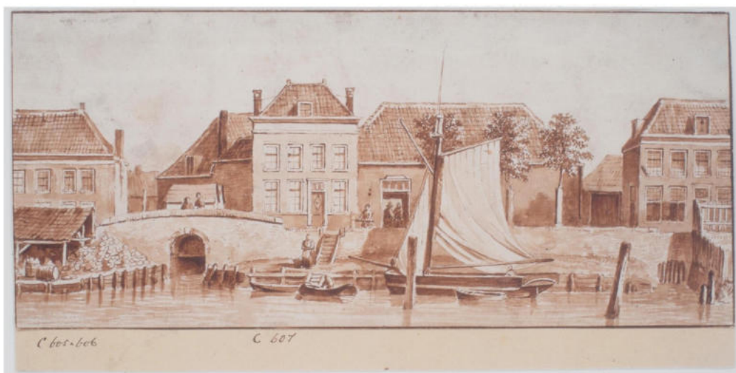
Afb. 13. Boven: palen van onder het sluisje en de stadsmuur. Midden: een constructiedeel van het sluisje. Beneden: de Snellesluis als voorbeeld voor hoe het sluisje er qua opbouw uit kan hebben gezien. Tekening: J. Rutten, ca. 1850. Regionaal Archief Dordrecht (551_30024).
