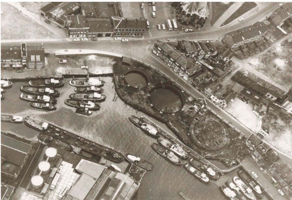
Afb. 5. Luchtfoto uit 1971 van de Riedijkshaven en omgeving, gezien naar het westen. Boven de Torenstraat, een deel van de Nieuwkerk en de Vest. Centraal de funderingen van de gesloopte gashouders aan de Bleijendoek. Het eerste huis rechts van waar de gashouders stonden, vertoont aan de achterzijde een aparte gebogen vorm. Eerder stond op die plaats de Barthout Loenistoren, een toren in de stadsmuur die rond 1894 gesloopt is. Het lijkt erop dat in het huis een deel van de (fundering van) de toren is opgenomen. Foto: Regionaal Archief Dordrecht (552_322697).
