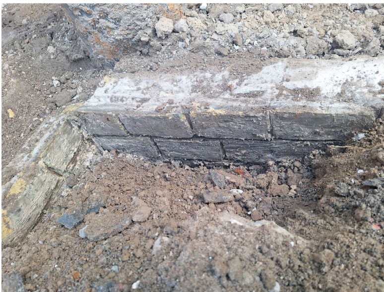
Afb. 22. Boven: de kelder S12 op vlakniveau gezien in noordwestelijke richting. Onder: de noordoostelijke hoek van het binnenwerk van de kelder met de bakstenen klamplaag (Dorst 2025, vakteam erfgoed).
