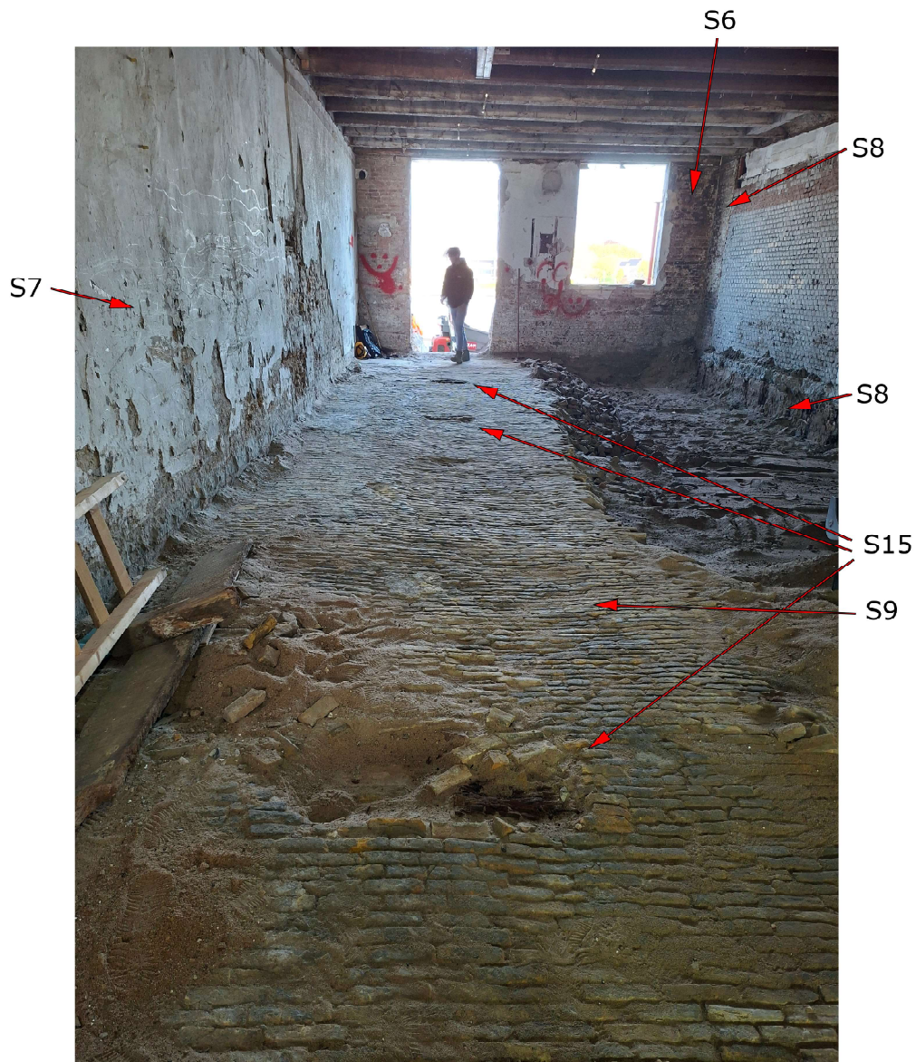
Afb. 25. De zuidelijke helft van de vloer S9 in de zuidelijke helft van het achterhuis, gezien in noordwestelijke richting, naar de Oude Maas. In de vloer zijn inkassingen met hout (S15) aanwezig (Dorst 2025, vakteam erfgoed).
