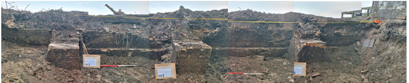
Afb. 21. Een binnenzijde aanzicht van het ondergrondse deel van de huidige kademuur. Het onderste deel is een restant van de 17 e -eeuwse kademuur-/borstwering S5 met daarop de jongere kademuurfase S1 en de bijbehorende steunberen S2, S3 en S4, zie ook afb.17 (Dorst 2025, vakteam erfgoed).
