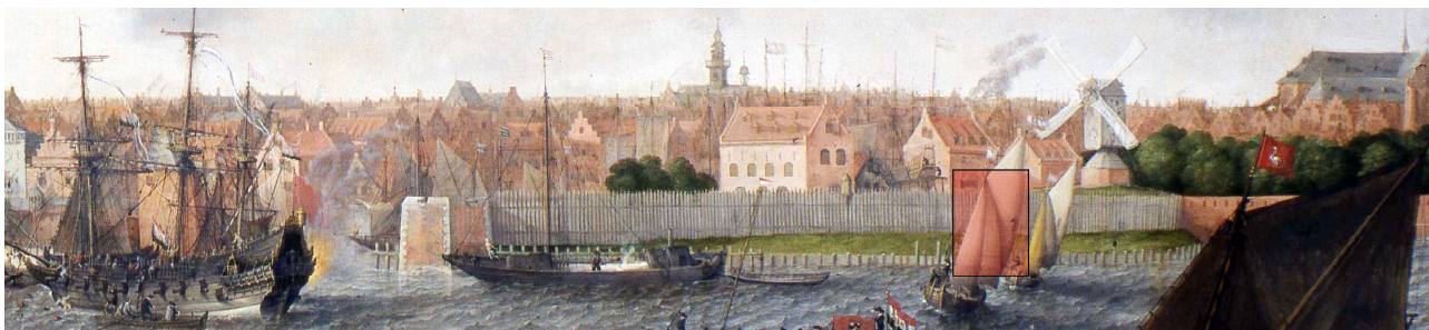
Afb. 7. Een uitsnede van een kaart van Willaert uit 1629 waarop de inrichtingssituatie Wolwevershaven te zien is. Het gebied van de huidige straat/kade Wolwevershaven is herkenbaar als de houten palissade met aan de haveningang (midden links) het bakstenen Damiatebolwerk. Voor de palissade is een mogelijk tweede fase van landwinning herkenbaar als een laaggelegen strook groen met een vlechtwerkbeschoeiing. In rood is bij benadering de locatie van het plangebied Wolwevershaven 31-33 aangegeven (Collectie Dordrechts Museum, objectnr. 842415, bewerkt door Dorst 2025).
