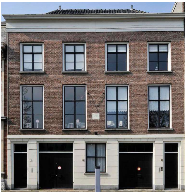
Afb. 14. De voorgevel van het pand pakhuys Oslo, Wolwevershaven 31-33 (Archief Vakteam Erfgoed gemeente Dordrecht, Monumentenzorg 2025).
