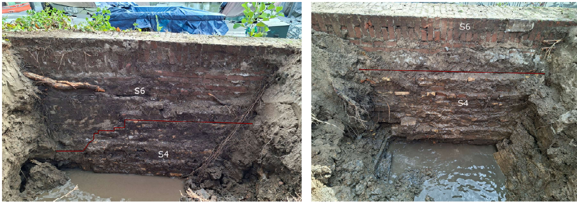
Afb. 31. De oostprofielen van de putten 1 (links) en 2 (rechts) met daarin de binnen-of landzijde van de huidige kademuur; onderin de oudste fase S4 en bovenin de jongere fase S6 (Dorst 2025, vakteam erfgoed).
