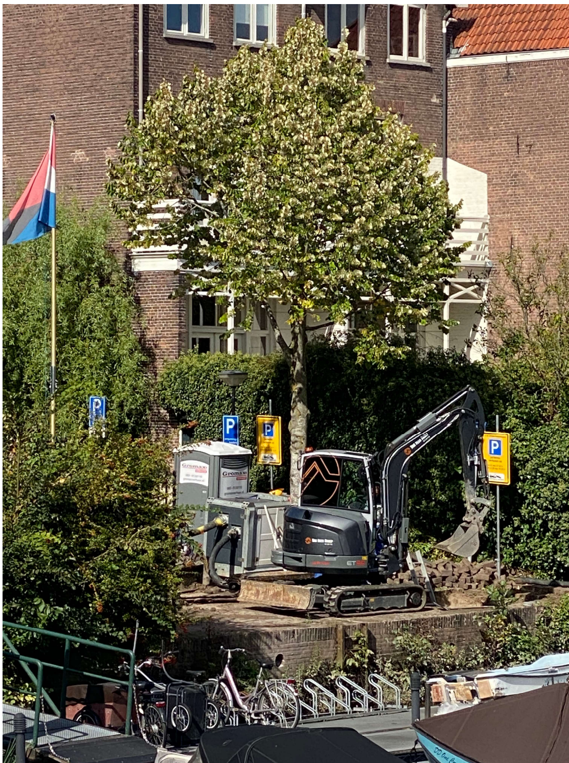
Het onderzoeksgebied ten tijde van de uitvoer van het veldwerk, gezien vanaf de Nieuwbrug (foto: mevr. Hoevenberg, vakteam erfgoed).
