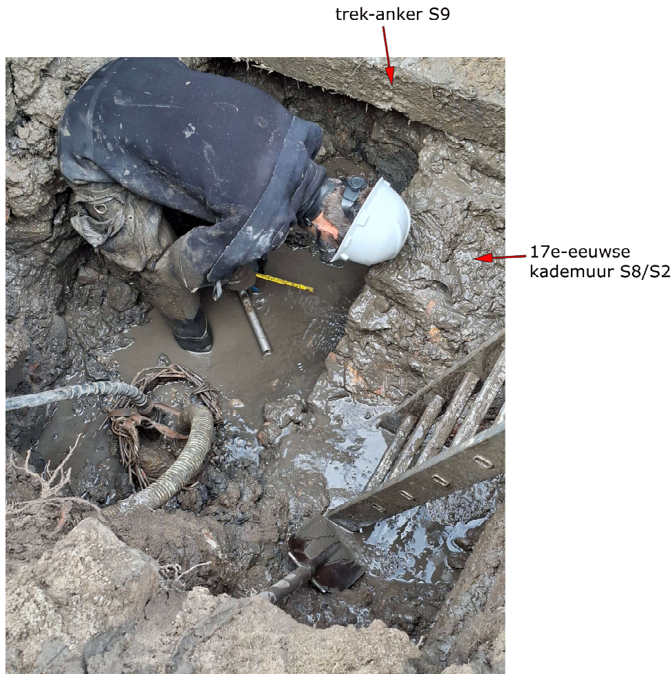
Afb. 29. Monsternamen van het funderingshout van kademuur S8 door dhr. Heijnen van Nebest. Daarboven is de liggende balk van het trek-anker (S9) van de latere kademuur S4 te zien (Dorst 2025, vakteam erfgoed).
