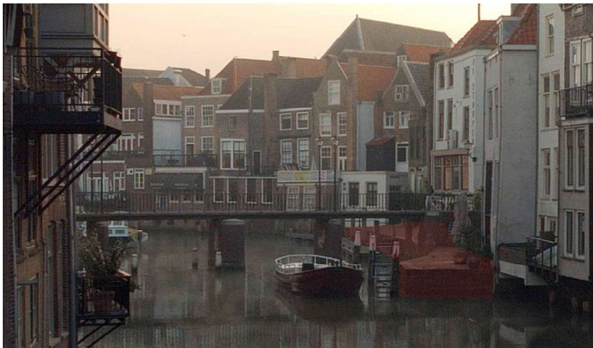
Afb. 17. Boven: de huidige Wijnbrug uit 1869, gezien rond 1900 vanaf het Scheffersplein (RAD inventarisnr. 551_30019, bewerkt door Dorst 2025, vakteam erfgoed). Deze is gebouwd op de funderingsresten van de bogen van de brug uit 1695. Het, vanaf links gezien, tweede doorvaartdeel is langer dan de andere drie delen; dit was het deel waarin in de 17 e -eeuwse Wijnbrug het mastgat zat (zie afb. 12 en afb. 13). Ter vergelijking is hieronder de Wijnbrug vanaf het Scheffersplein in het jaar 2025 weergegeven (gemeentelijk geo-informatiesysteem Drechtmaps Geo-Apps 1.0, 2025). In beide is het plangebied Grote Appelsteiger in rood aangegeven.
