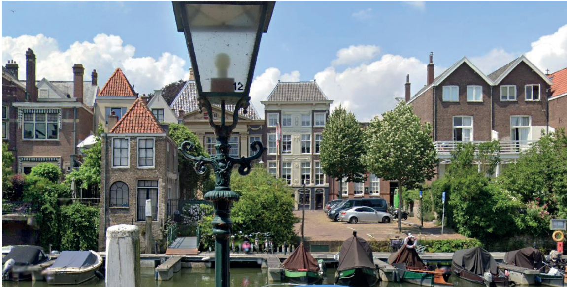
Afb. 23. Een aanzicht op de Kraansteiger in 2022, gezien vanaf de Taankade (Foto: Google Maps 2022).
