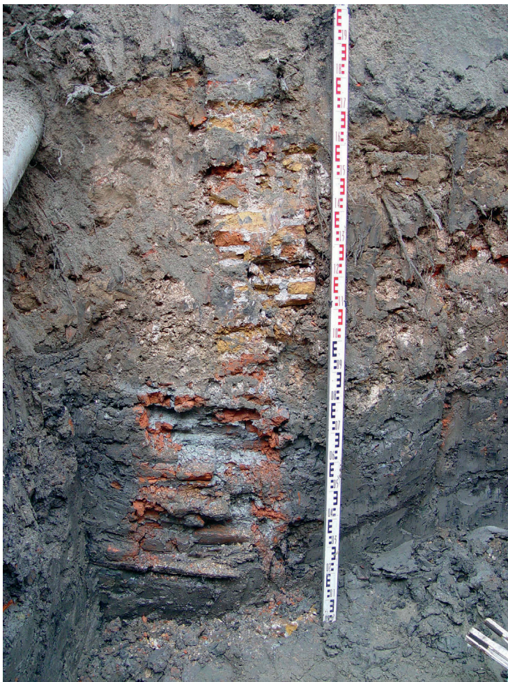
Afb. 24. Een profielaanzicht van de containerlocatie op de Kraansteiger tijdens de begeleiding in 2002. Hierin is een doorsnede van het aangetroffen muurwerk op een houten plankfundering te zien (Foto: Bureau Monumentenzorg & Archeologie, gemeente Dordrecht, 2022).
