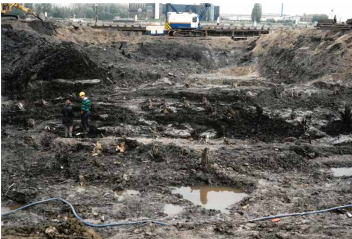
Afb. 43a t/m e. Foto's van de afgraving van de sterk vervuilde grond ter hoogte van de gasfabriek. Hierbij kwamen diverse houten constructies tevoorschijn. Foto beneden: L. Brand.
