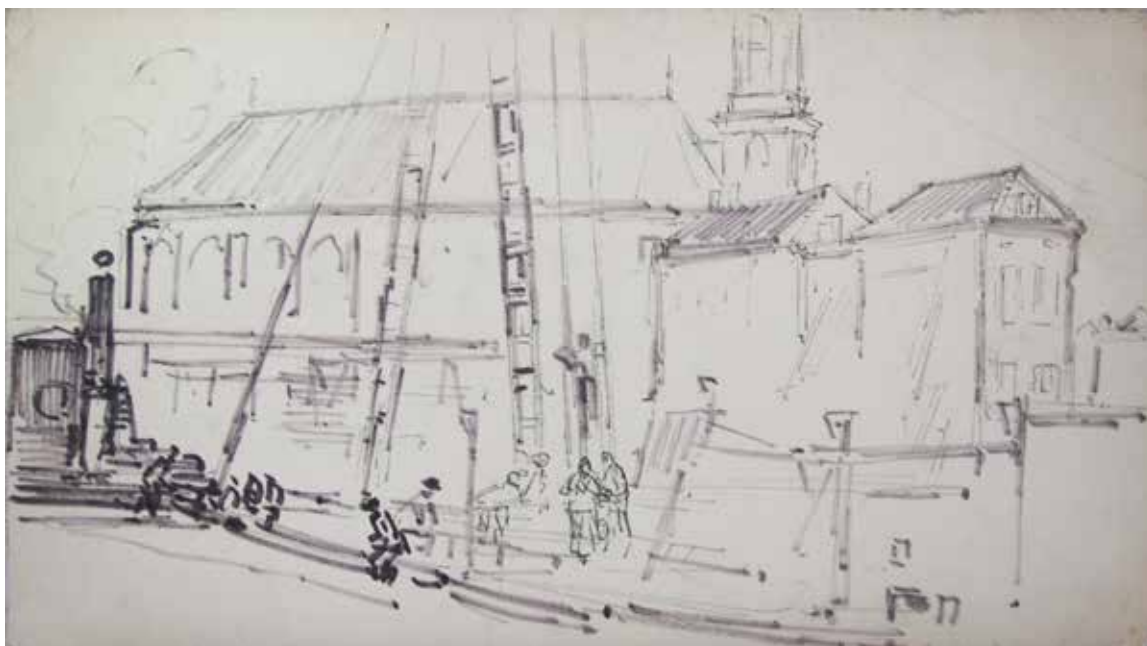
Afb. 19. Cor Noltee tekende aan de Torenstraat het moment van het heiwerk waardoor de Pellentoren werd ontdekt. Foto: C. van der Esch.
