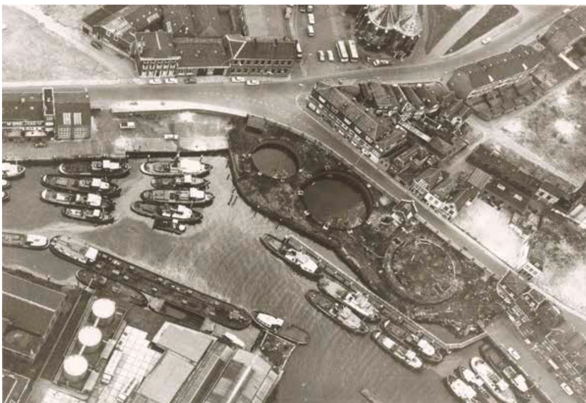
Afb. 5. Luchtfoto uit 1971 van de Riedijkshaven en omgeving, gezien naar het westen. Boven de Torenstraat, een deel van de Nieuwkerk en de Vest. Centraal de funderingen van de gesloopte gashouders aan de Bleijendoek. Het eerste huis rechts van waar de gashouders stonden, vertoont aan de achterzijde een aparte gebogen vorm. Eerder stond op die plaats de Barthout Loenistoren, een toren in de stadsmuur die rond 1894 gesloopt is. Het lijkt erop dat in het huis een deel van de (fundering van) de toren is opgenomen. Foto: Regionaal Archief Dordrecht (552_322697).
