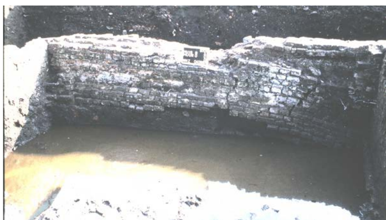
Afb. 33. De sterk verzakte achtergevel van het huis op perceel B, gezien vanuit het pand in de richting van de Kolfstraat. Rechts is het varken en een deel van de nieuwe muurfase te zien.
