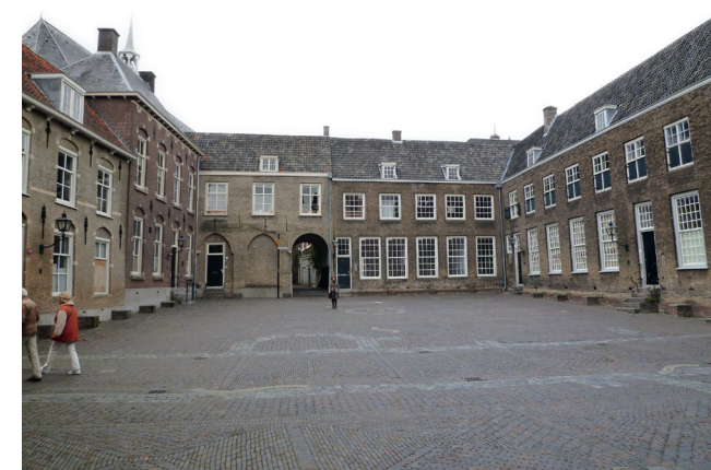
Afb. 15 Het Hof in Dordrecht. Linksachter de twee gotische spitsbogen van de kloosteromgang. In het plaveisel de contouren van de kloosteromgang, het lavatorium en de centrale waterput (foto: Gemeente Dordrecht).
