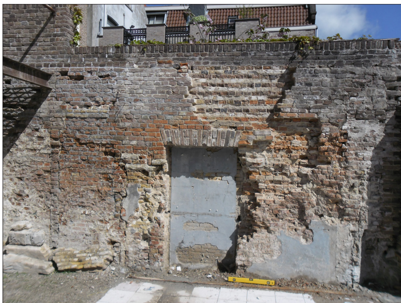
Afb. 17. Een deel van de oorspronkelijke zijmuur van het achterhuis was voorafgaand aan de werkzaamheden nog als opgaand muurwerk aanwezig en diende als erscheiding tussen Voorstraat 106 en 104. In de muur zijn verschillende doorgangen te zien. Links de dichtgezette doorgang S4 (zie ook afb. 12).
