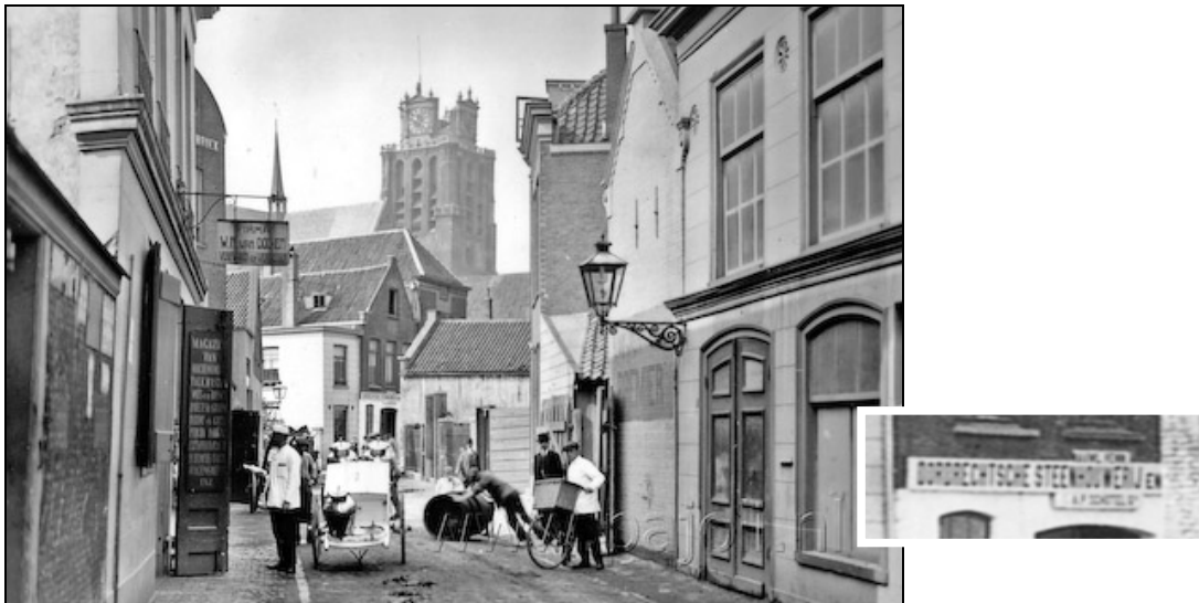
Afb. 12 Houttuinen-hoek Schuitenmakersstraat, circa 1915 en detail geveltekst Houttuinen nr. 20. (DiEP Erfgoedcentrum)
